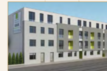
2 Mehrfamilienhäuser mit Tiefgarage, Dossenheimer Landstraße 73 – 75, Heidelberg
