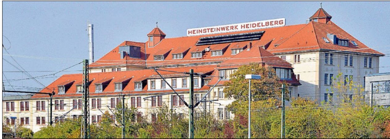
Als Industriedenkmal saniert und neu genutzt: das Heinsteinwerk im Ochsenkopf. Dieses Kapitel Heidelberger Industriegeschichte will das Stadtarchiv in einem Buch dokumentieren und sammelt noch weitere Unterlagen. Foto: Bechtel
