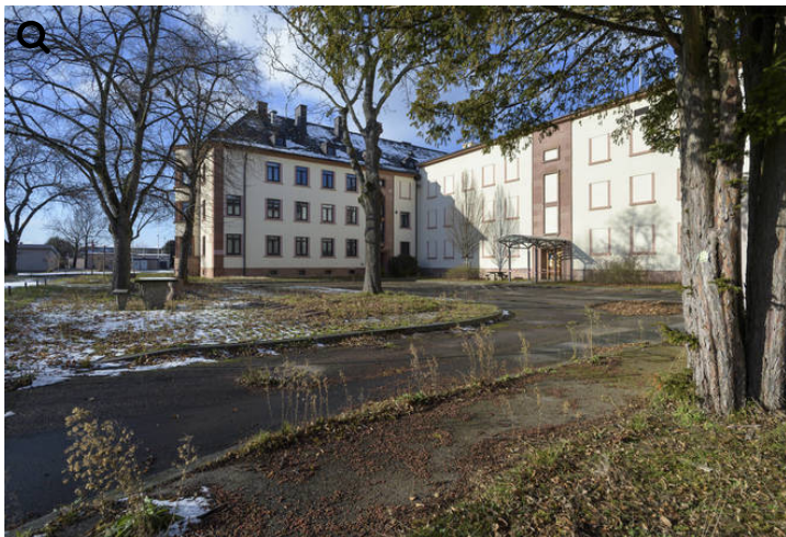
In diesem H-förmigen Bau im Nordosten des Areals, das der Investor BPD entwickelt, soll auch ein Boardinghouse unterkommen. F: Rothe
