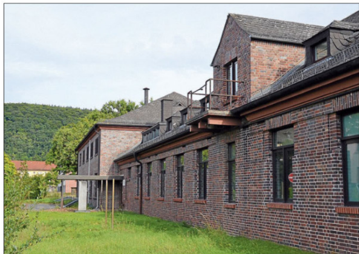
Das Gebäude 16 auf den Campbell Barracks: In einem Jahr soll hier eine Kindertagesstätte eröffnet; der Umbau läuft bereits. Foto: ste
