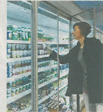
Glastüren vor den Kühlregalen sparen Strom
