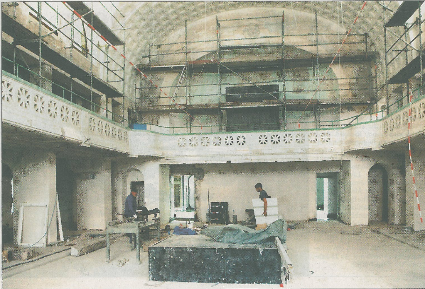
Noch ist das gesamte alte Hallenbad eine einzige große Baustelle – kaum zu glauben, dass das Hotel schon in wenigen Tagen und das erste Restaurant in drei Wochen eröffnen soll. Das Foto zeigt das Männerbad, in dem es ab Mitte September eine Markthalle geben wird. Foto: Alex
